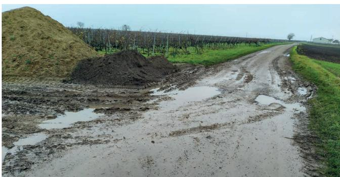
Der Zustand der Bankette soll so beschaffen sein, dass ein ungehindertes Abfließen der Oberflächenwasser von der Fahrbahn möglich ist.
